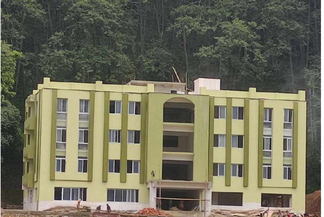
चित्र १: मातातीर्थस्थित निर्माणाधीन कलेज भवन
